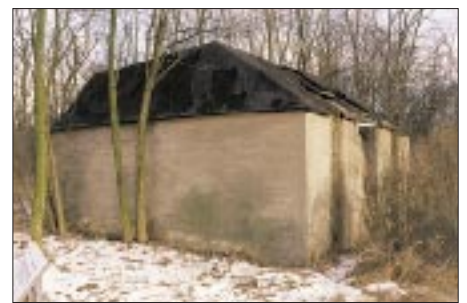
Die Betonsockel des ehemaligen Mittelturms erreichen beinahe die Größe eines Einfamilienhauses.
