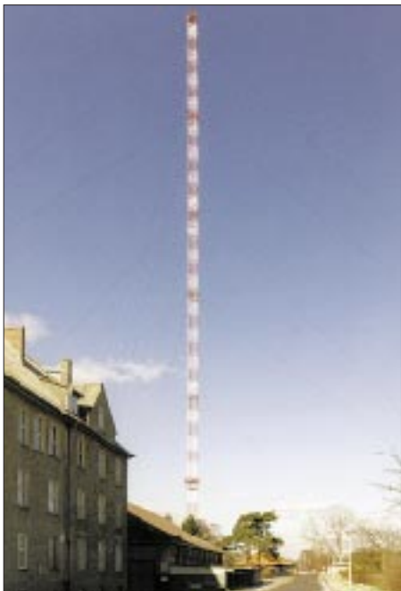
Der 210-m-Antennenmast ist der letzte seiner Art
